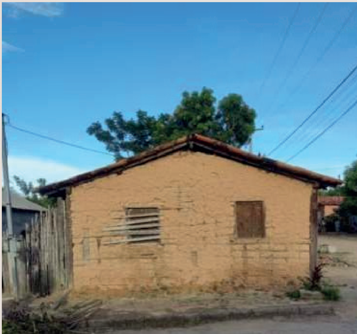
Figura 2: Residência de taipa.
